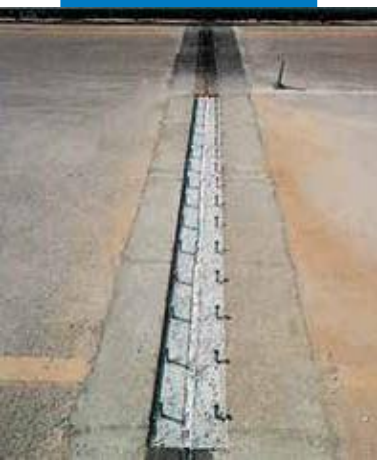
Reparación de juntas de puentes de rutas con Mapefill E
