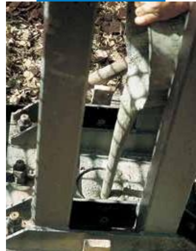
Anclaje con Mapefill E
