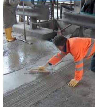
Aplicación de la mezcla confeccionada con Mapegrout SV100
