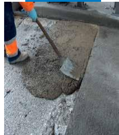
Alisado de la superficie de acuerdo a las guías preparadas anteriormente
