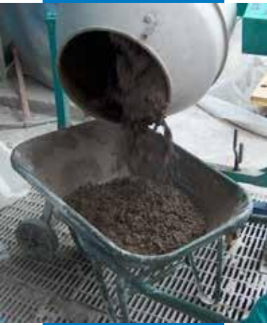
Mezcla de Mapegrout SV100 en hormigonera
