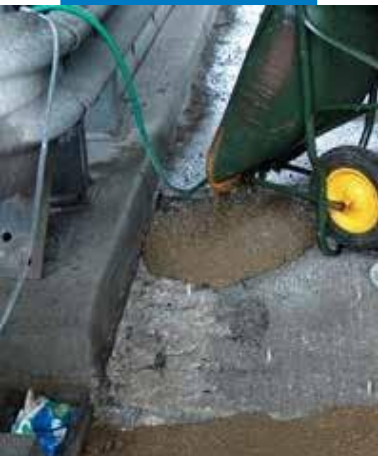
Volcado de Mapegrout SV100 en el área preparada
