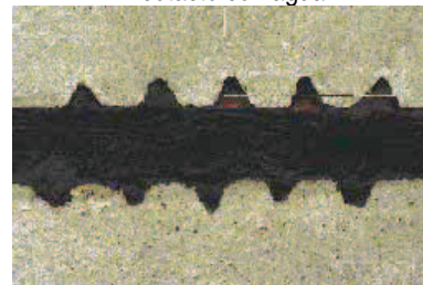
Grietas selladas por expansión de MASTERFLEX 610
